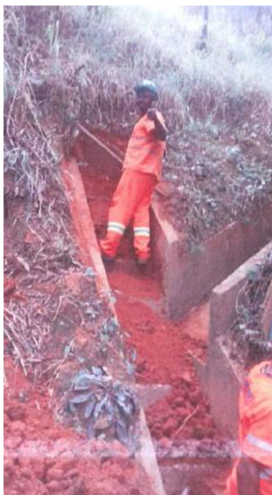
Foto 4 – Limpeza Drenagem - Km 101
