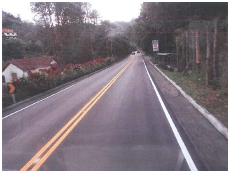
Foto 1 – Restauração do Pavimento - Km 68 ao 72
