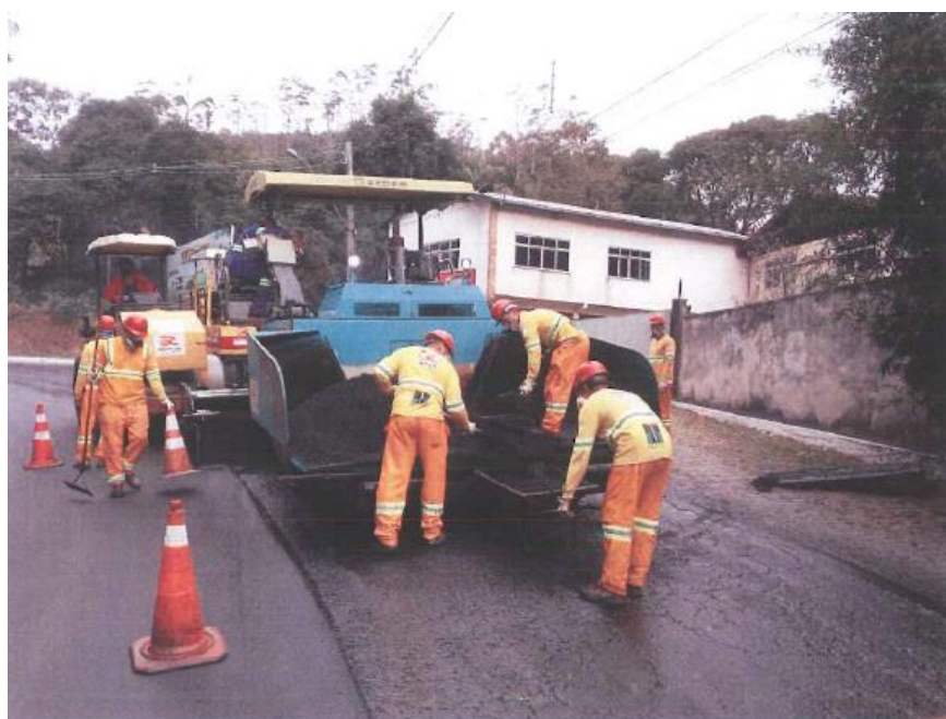
Foto 2 – Restauração do Pavimento - Km 73 ao 74
