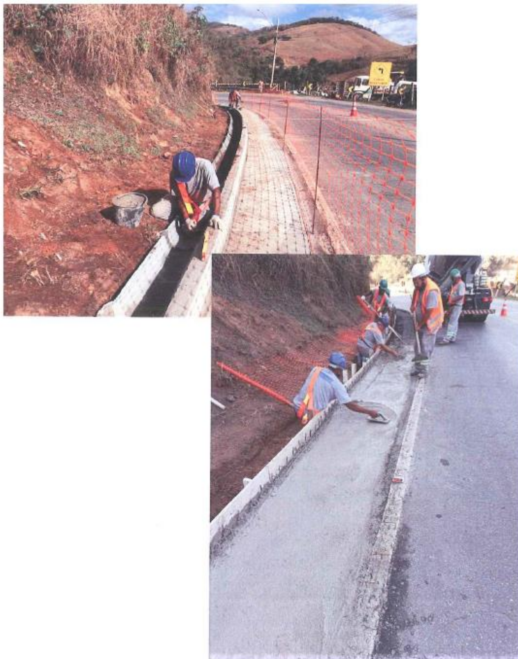
Foto 5 – Restauração de Dispositivo de Segurança - 132+500
