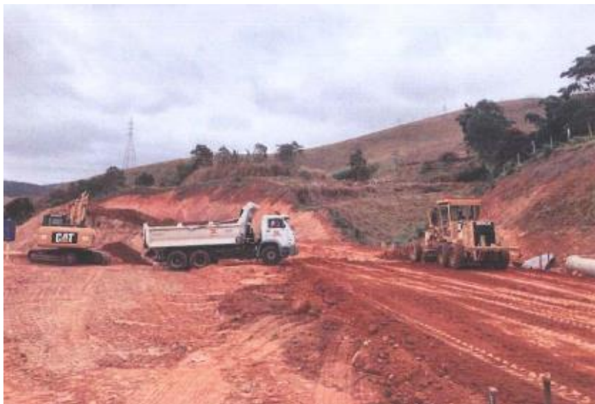
Foto 6 – Adequação da Interseção Cordeiro A - 123+300 [1]
