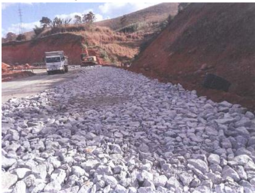
Foto 7 – Adequação da Interseção Cordeiro A - 123+300 [2]
